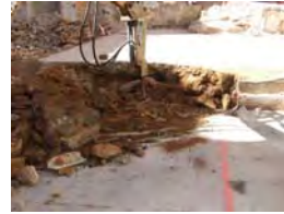
DSCF1926 Cala 1 Rebaix mecànic
