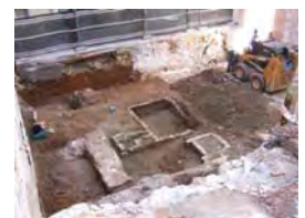
DSCF1989 Nivell Superior estructures
