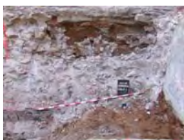
DSCF1986 Perfil Nord Solar 6
