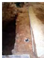
DSCN2606 Mur u.e. 2004
