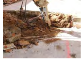
DSCF1927 Cala 1 Rebaix mecànic
