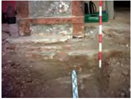
PIC01409 Fonamentació 1042 Pilastra
