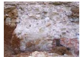
DSCF1984 Perfil Nord Solar 4
