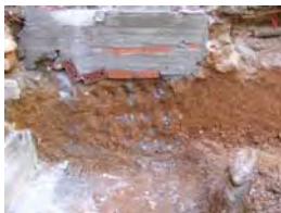
DSCF1981 Perfil Nord solar 1
