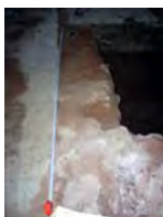
DSCN2604 Mur u.e. 2004
