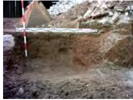
PIC01411 Detall rasa fonamentació
