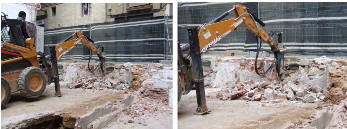
Dues imatges durant el procés d'excavació de la Riostra 1
