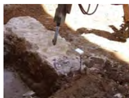
DSCF2023 Afectació mur 1027
