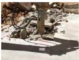
DSCF1928 Cala 1 rebaix mecànic
