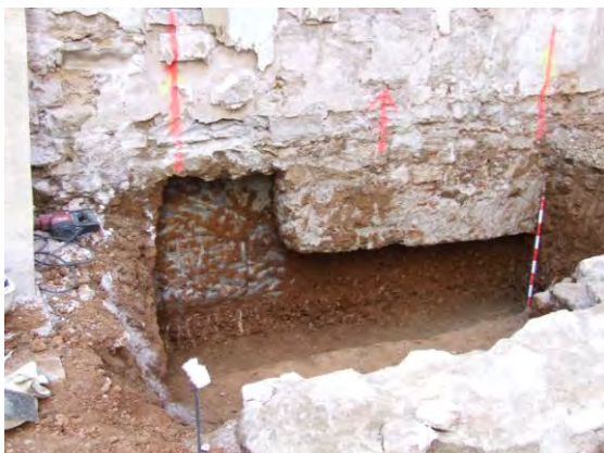
Vista de la banqueta de fonamentació u.e. 1032 del mur u.e. 1031 a l'esquerra i la rasa de fonamentació de la banqueta u.e. 1032 a la dreta
