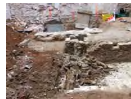
DSCF2019 Afectació estructures
