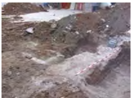
DSCF1968 Cala 5 mur i dipòsit
