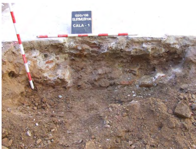
Vista del perfil Nord oest de la Cala on s'observa el paviment, la preparació i la solera de formigó
