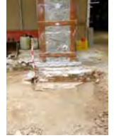
DSCF2035 Pilar 1041, fonam 1042 i pav 1043
