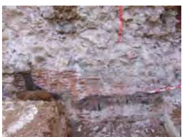
DSCF1985 Perfil Nord Solar 5
