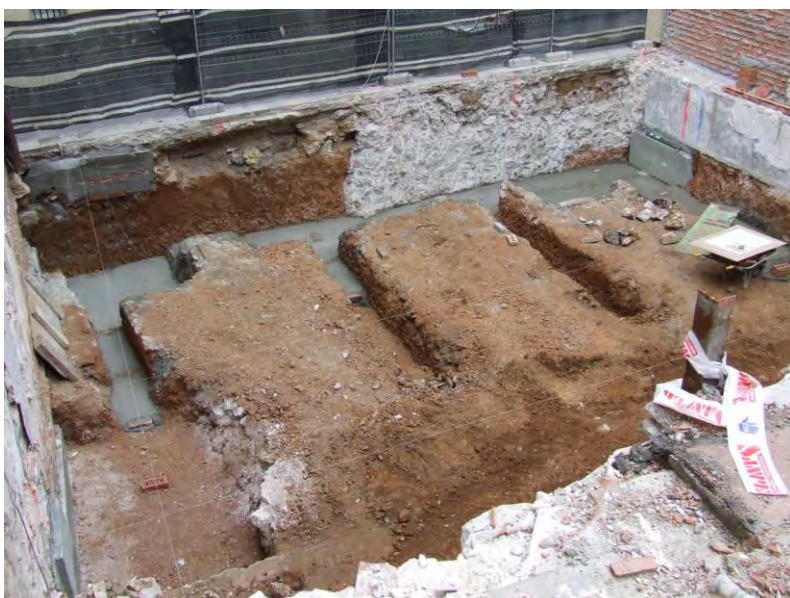
Vista final de les riestres 3, 5, 6 i 2 un cop efectuades
