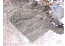
DSCF1962 Cala 2 Buidatge farciment dipòsit
