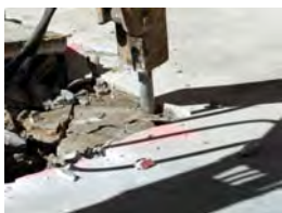
DSCF1929 Cala 1 rebaix mecànic
