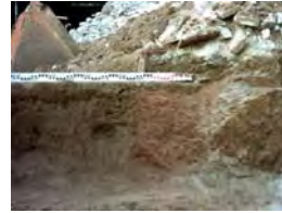
PIC01412 Detall rasa fonamentació
