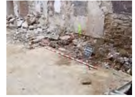
DSCF1957 Cala 5 extracció paviment
